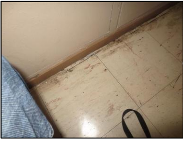
Photo N° 1285 REVETEMENT DE SOL --paliers +1 à +5 Planchers Dalles de sol 30x30 avec colle noire
